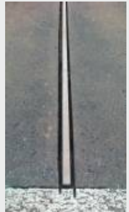
Stanowisko pomiarowe z wbudowanymi czujnikami piezo
